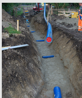
2.250 m Druckleitung DN200
